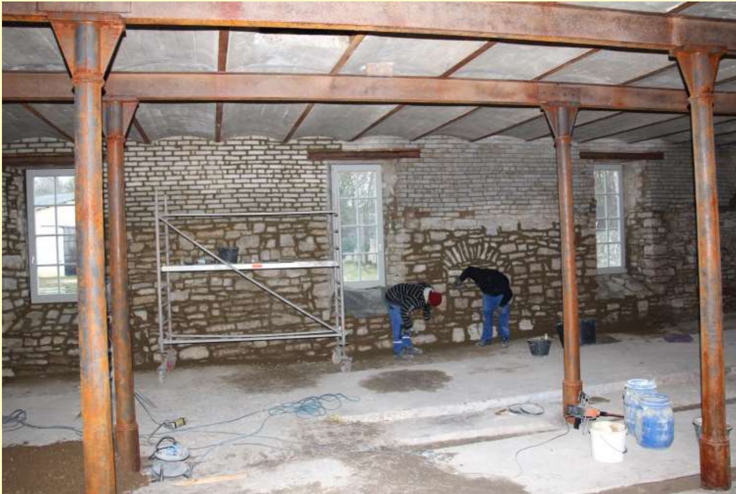
2016 – Beginn der Bauarbeiten
