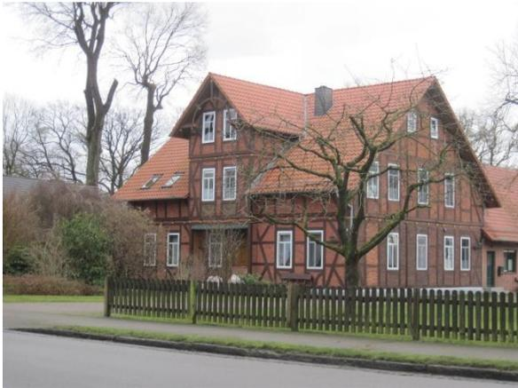
Fassade in Fachwerk mit Ausmauerung
