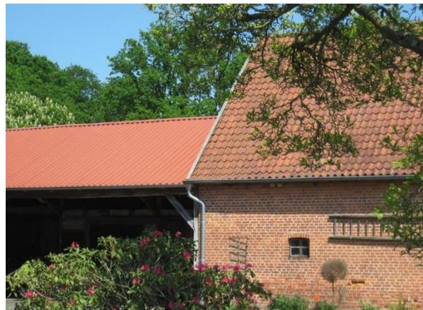
Kombination von Tonziegeln und farblich angepasstem Profilblech beim Schauer
