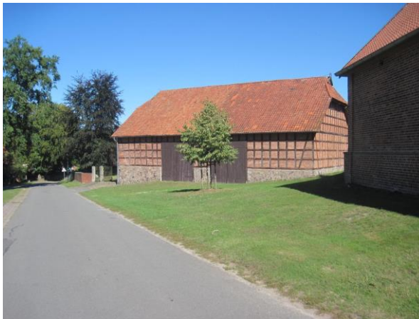
Nebengebäude mit Boden-Deckel-Schalung
