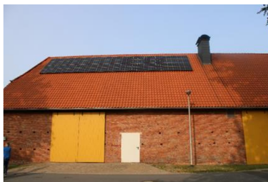
Abb. 2-8: Dach-PV-Anlage und Holzhackschnitzelheizanlage für ein Wärmenetz in Neddenaverbergen
