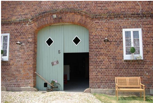
„Groot Dör“ mit Klöntür und Oberlicht
