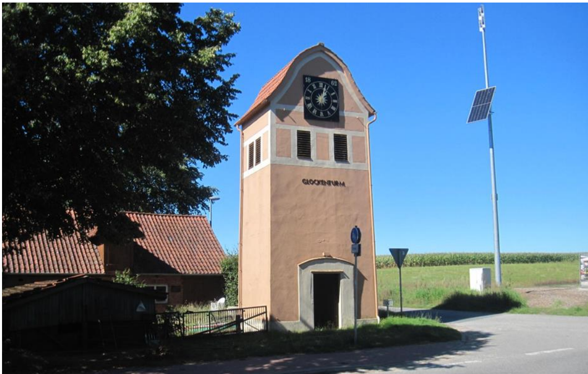
Der Glockenturm markiert den Beginn des Ortskerns von „Nedden“ aus Richtung Kirchlinteln kommend.
