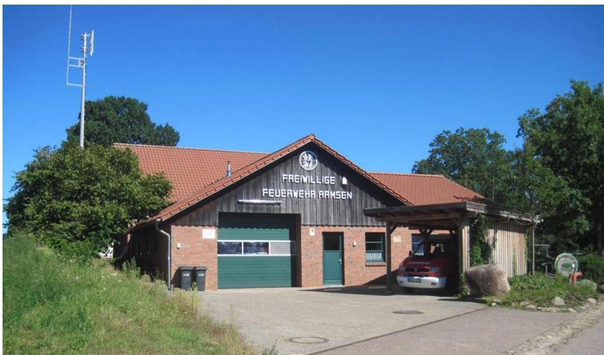
Feuerwehr, Dorfgemeinschaftshaus und dazugehörige Freianlagen sind seit ihrem Entstehen der Mittelpunkt des dörflichen Gemeinschaftslebens.
