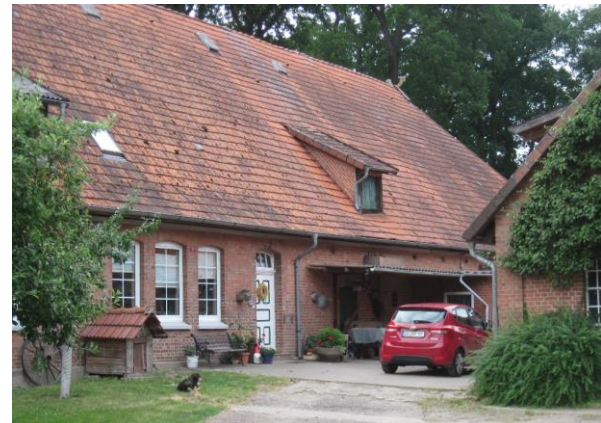
Kleiner Ladeerker als Zugang zum Dachraum
