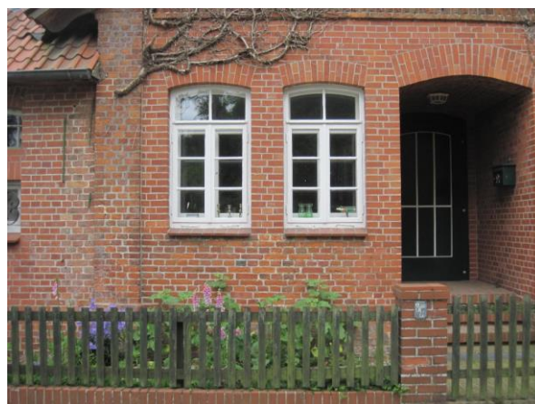
Erneuerte Fenster in einer Ziegelfassade
