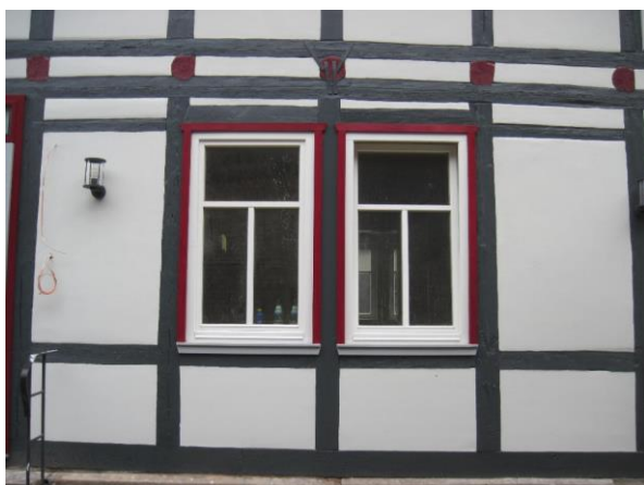
Fenster mit T-Teilung in einer Fachwerkwand
